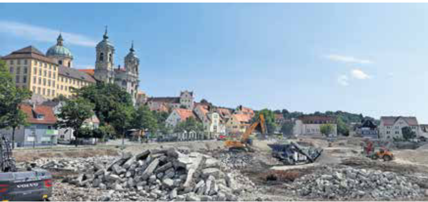
Blick auf die Baustelle, fotografiert von der Schuler-Kantine.
