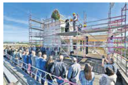
Richtfest am Erweiterungsbau der TWS in der Ravensburger Bahnstadt.
