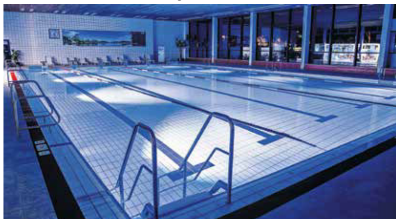
Die neue Unterwasserbeleuchtung im Schwimmerbecken zaubert eine besondere Atmosphäre.
