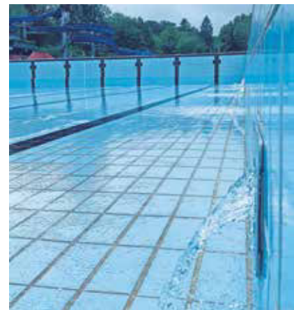
Wasser marsch! Anfang der Woche sind die Becken gefüllt worden, hier das Schwimmerbecken.
